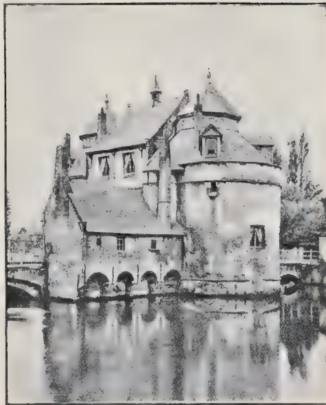
Bruges: Porte des Baudets.
